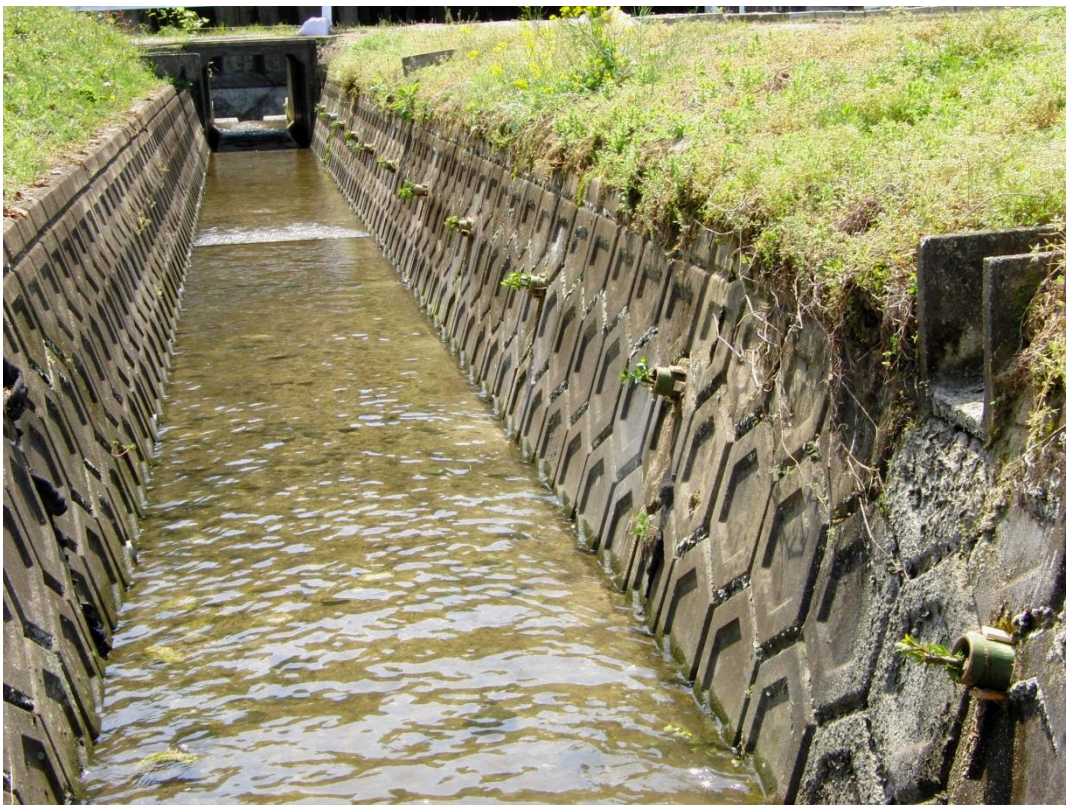
中島地区水路（ネコヤナギ植栽直後に上流部から撮影）
