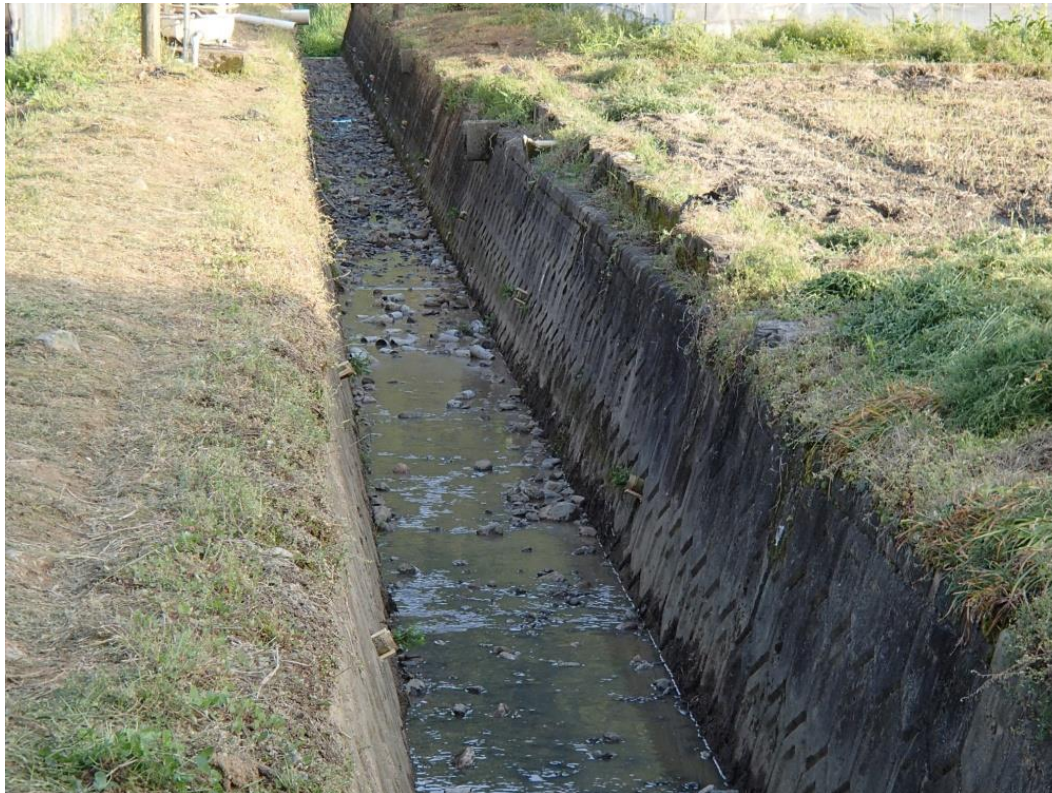
河床改変完了後の水張り
