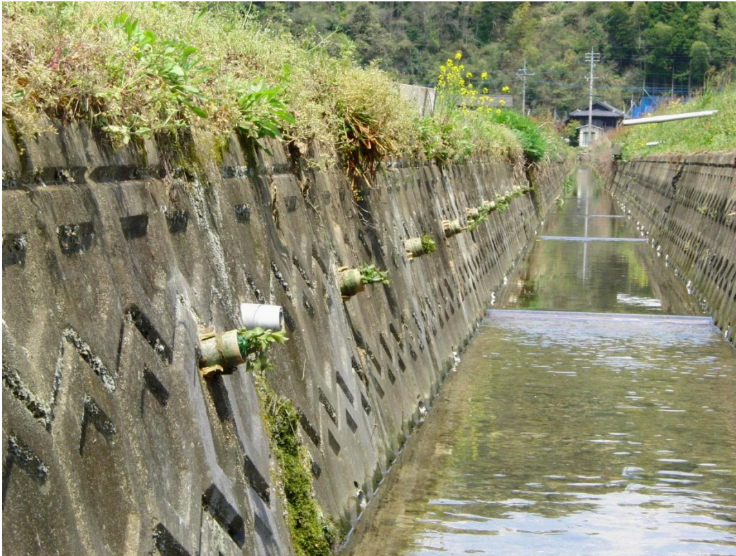
中島地区水路（ネコヤナギ植栽直後に下流部から撮影）
