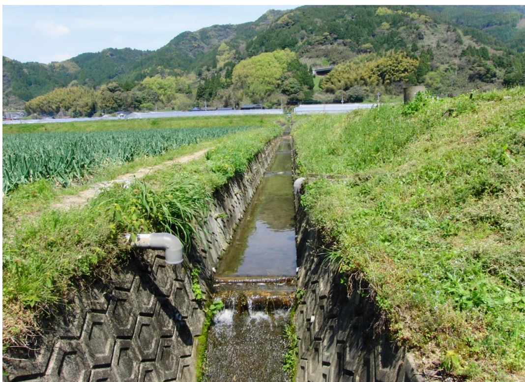
広瀬地区水路（最下流から上流部を望む）
