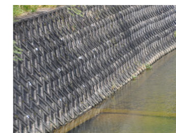
無機質なコンクリート護岸
