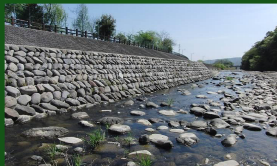
2009年3月施工 ▼ 3年経過
