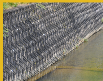
無機質なコンクリート護岸
