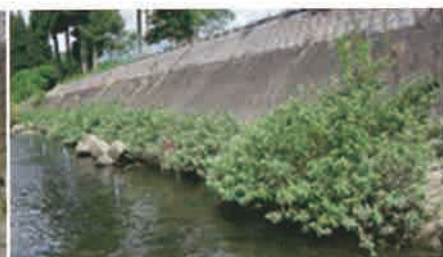
写真11 3年6ヶ月経過時の繁茂状態
