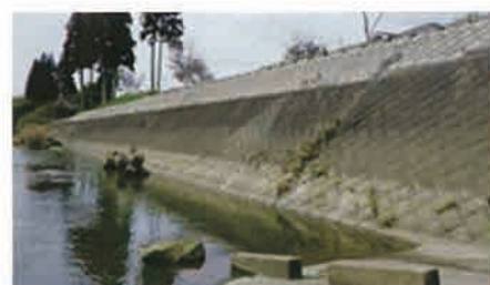
写真10 植栽施工直後の状態
