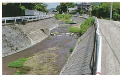
写真1 ブロック積の既設護岸
