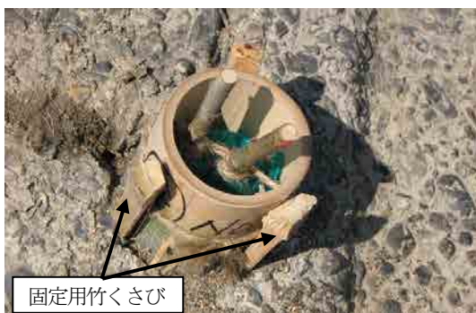
写真-4 竹ポット構造体の竹くさびによる一次固定
