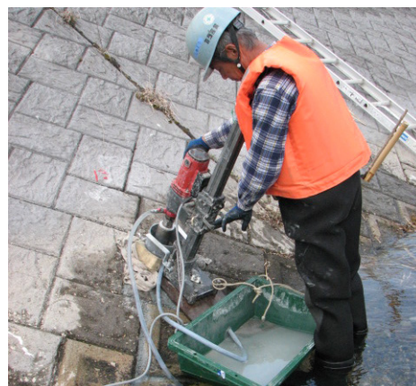
写真-1 護岸への穿孔方法(改良後)
