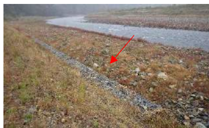
カゴマツト (全体像) (下流側から撮影)
