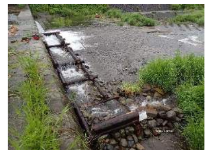
木杵土嚢魚道
