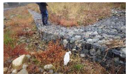
カゴマツト (拡大) (上流側から撮影)
