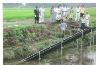
可動式魚道の設置状況
