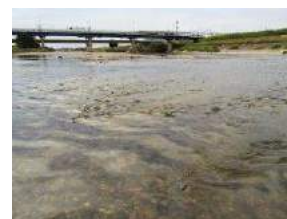
施工後に形成された瀬
