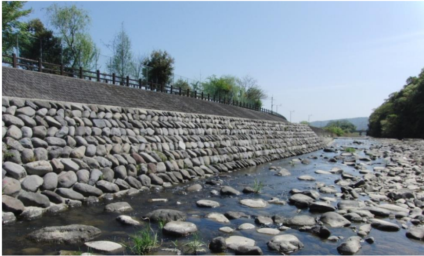
2009.08.19 撮影 施工前の玉石積区間
