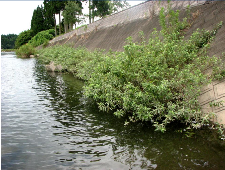
写真一No.6 せんだい 川内川 鶴田地区右岸側護岸での繁茂状況 2010.8 施工 撮影日：2013.07.22（3年経過時）（国土交通省川内川河川事務所）
