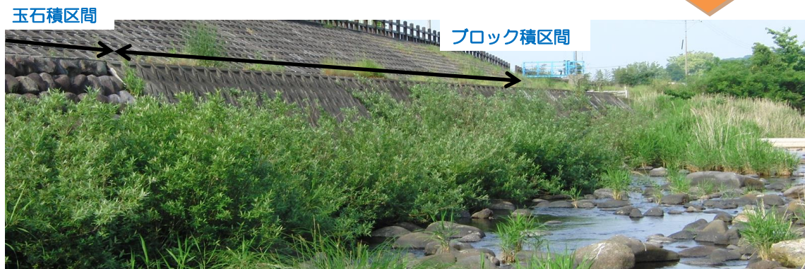
2012.05.30 撮影 3年経過時には玉石積とブロック護岸が見えていた。
